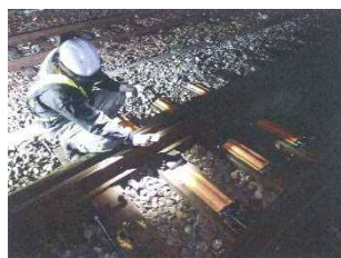
電気融雪器更新工事①
