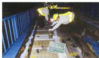
レール交換作業
