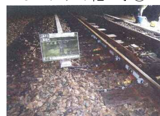
電気融雪器更新工事②
