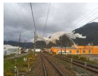
上田駅～西上田駅間 架線に掛ったビニールハウス
