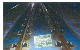
レールと締結装置交換後
